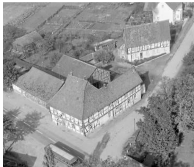
Steht größtenteils nicht mehr: Das Gasthaus „Brauner Hirsch“ an der Bundesstraße in Hammenstedt im Jahre 1964. Repro: Karl Nolte/Inh
